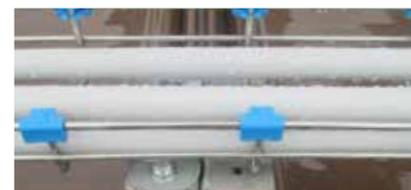
Nel caso di impianto esterno, la linea sopra descritta è inserita all'interno di un tubo in PVC.
