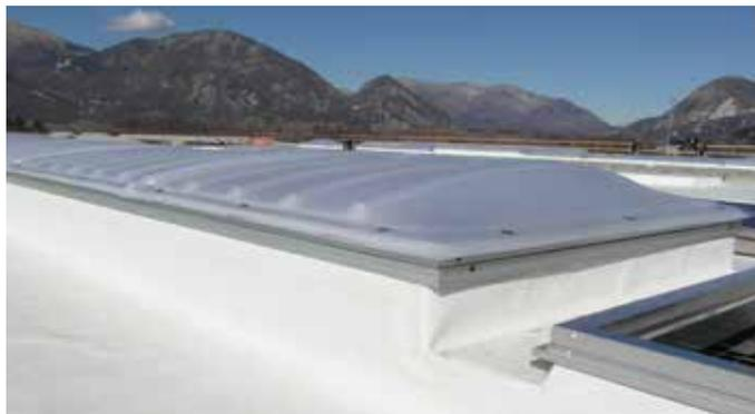
I lucernari continui costituiscono la soluzione ideale per ottenere un'illuminazione naturale diffusa nei locali di ampia superficie a cui abbinare le funzioni di ventilazione ed evacuazione naturale di fumo e calore.
