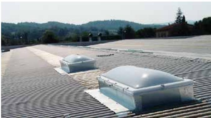
Basamenti da comporre in opera realizzati con sezione a C in lamiera di acciaio Zincata o preverniciata bianco/grigio standard.
