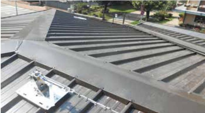
I punti di ancoraggio in classe A1 ed A2 sono progettati per essere fissati a superfici verticali, orizzontali e inclinate.
