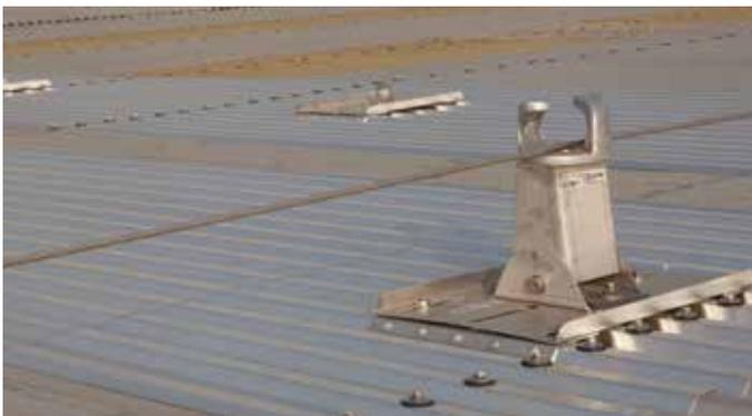
La classe C comprende dispositivi che utilizzano linee di ancoraggio flessibili orizzontali, che non deviano dall'orizzonte per più di 15°, può essere utilizzata da un massimo di tre operatori contemporaneamente.
