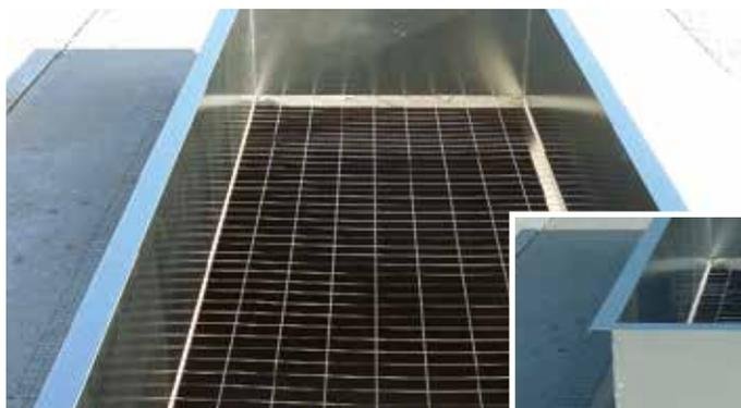
Rete elettrosaldata zincata prima della saldatura con filo diam. mm 2, maglia mm 50x100, ancorata con listelli in legno e tasselli sul solaio in CLS
