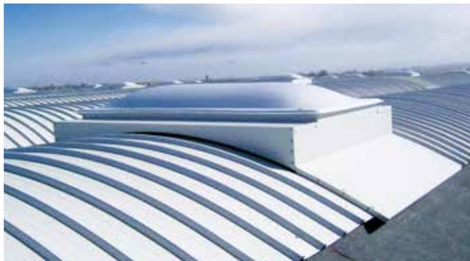
Basamento da comporre in opera realizzato con sezione a C in lamiera zincata o preverniciata bianco/grigio standard, fissato su barella piana realizzata con profili tubolari ancorati, alle due estremità, mediante tasselli.
