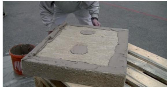
Applicazione della calce idraulica (NHL) naturale come adesivo ai pannelli, la stessa che viene poi utilizzata per la rasatura.
