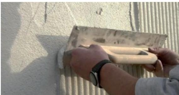
Rasatura con calce idraulica naturale, in cui viene affogata la rete di armatura in fibra di vetro.
