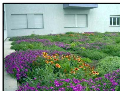
Da un punto di vista tecnico le prestazioni sono simili a quelle del prato pascolo, anche se la manutenzione in fase iniziale è sicuramente più elevata. Anche in questo caso si raccomanda una particolare attenzione all'impiego di piante autoctone. La soluzione, conserva un certo carattere di artificiosità, mantenendolo ad un livello ecologico inferiore rispetto al prato, ma se ben progettata dal punto di vista botanico, può avere notevole valore estetico e buona valenza ecologica.
