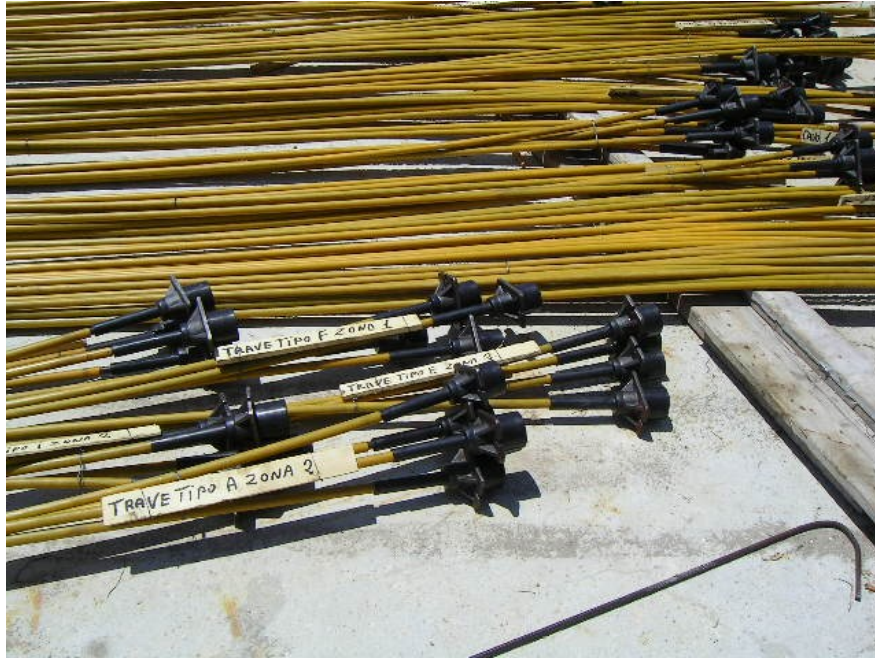
Figura 13: preparazione del trefolo in cantiere con taglio a misura
