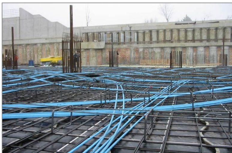
Fig. 21: Posa dei trefoli viplati e posa dei distanziatori per la posa dell'armatura di estradosso
