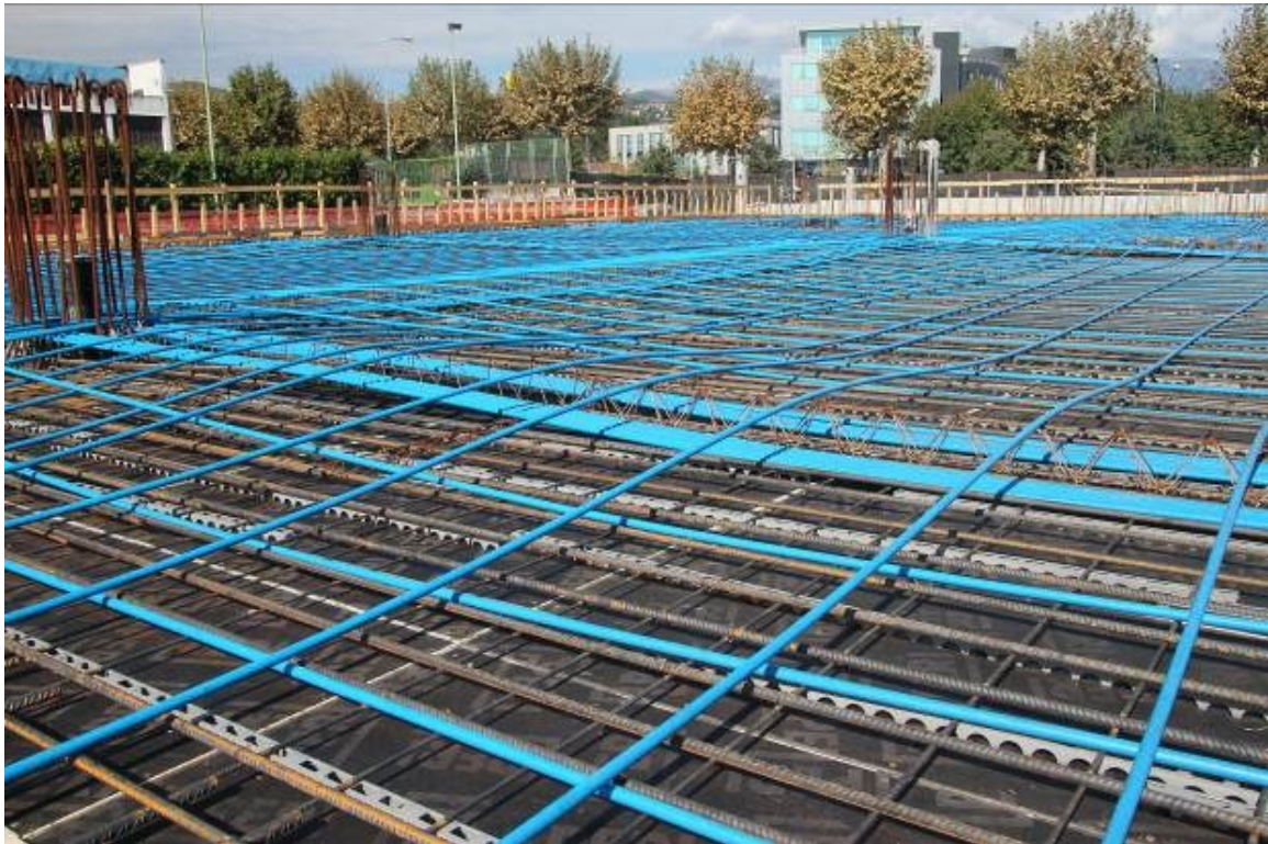
Nuova sede BMW a Castagnole (CN): posizionamento dei trefoli sul solaio
