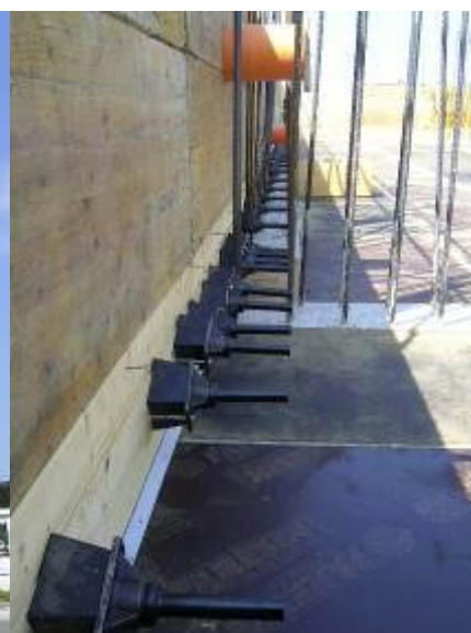
Posizionamento ancoraggi sui casseri
