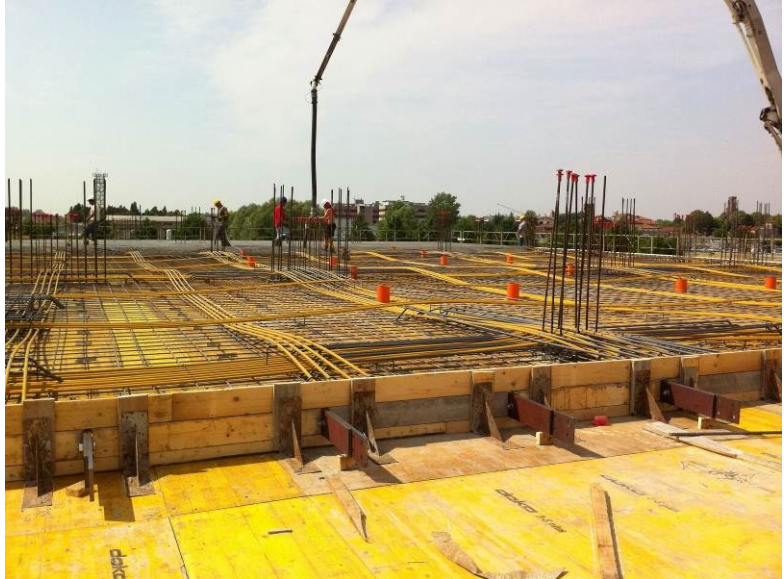
Fig. 9: giunti provvisori da posizionare prima del getto
