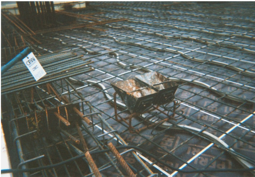
Fig. 19: Posa dell'armatura ordinaria di intradosso
